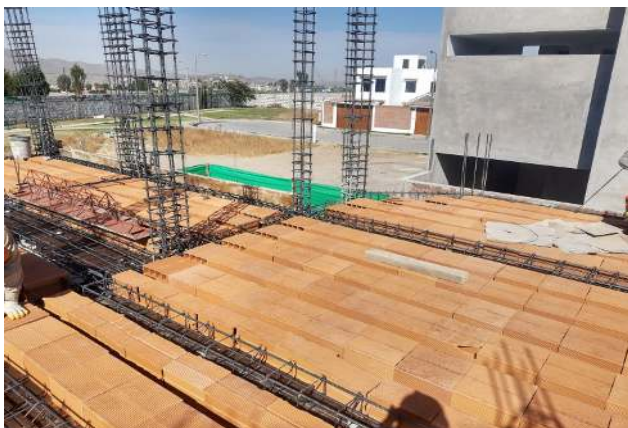
ACERO EN VIGAS
