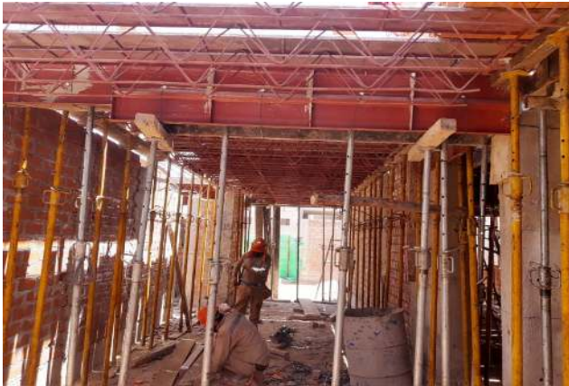
ENCOFRADO METALICO DE LOSA
