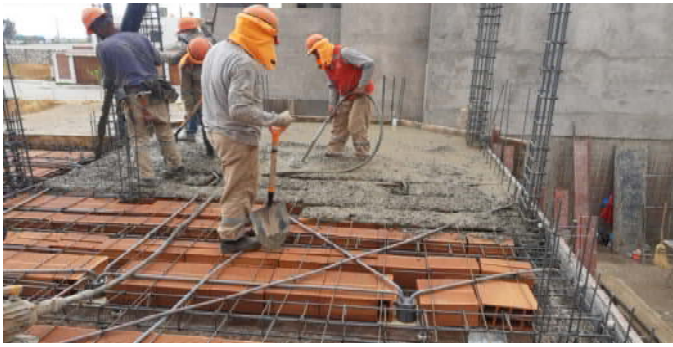
VACIADO DE LOSA CON MIXER
