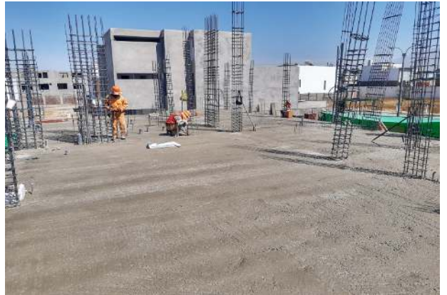
LOSA VACIADA AL 100%
