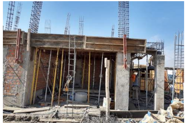
ENCOFRADO DE VIGAS PERALTADAS COLUMNAS
