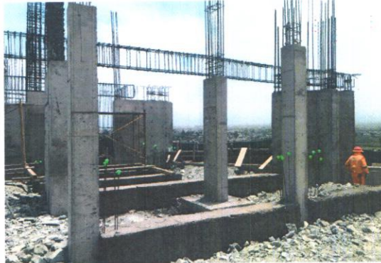
4.- COLUMNAS VACIADAS
