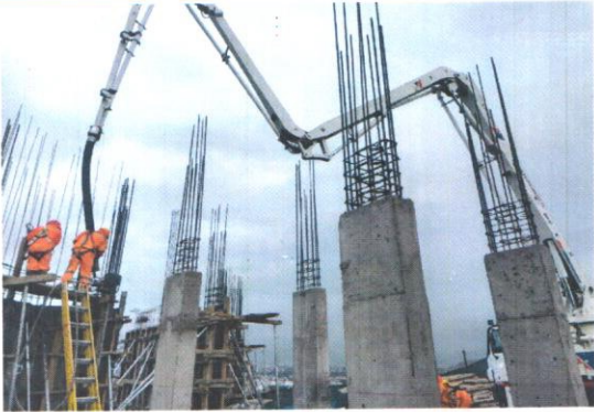
1.- VACIADO DE PLACAS Y COLUMNAS
