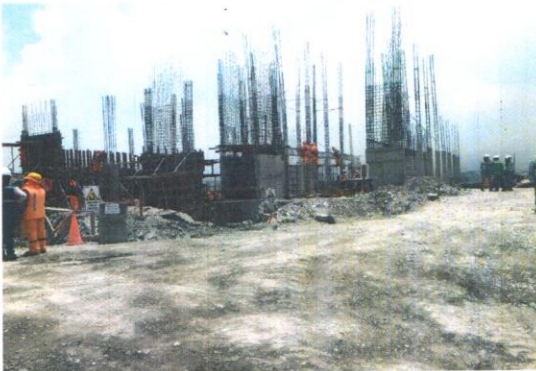
8.- PLACAS COLUMNAS Y MUROS, INICIO ENCOFRADO DE TECHO 1º NIVEL
