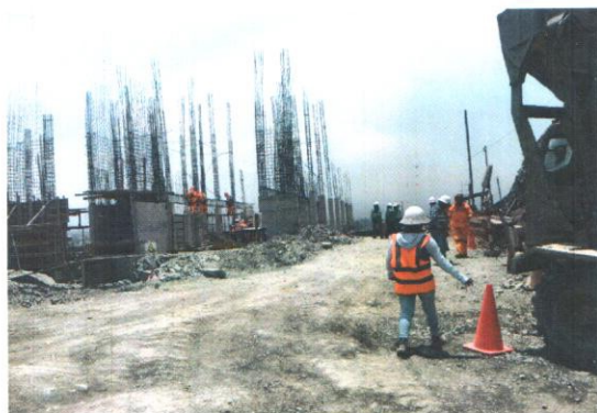
7.- PANORAMICA DE PLACAS Y COLUMNAS 1º NIVEL
