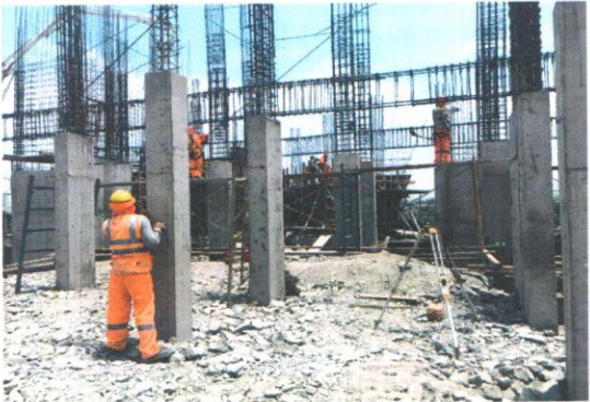
3.- COLUMNAS PLACAS Y INICIO DE ARMADURA DE VIGAS 1º NIVEL
