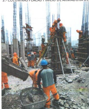
5.- ENCOFRANDO COLUMNAS SECTOR 2
