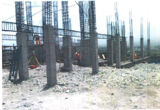
2.- COLUMNAS AISLADAS VACIADAS
